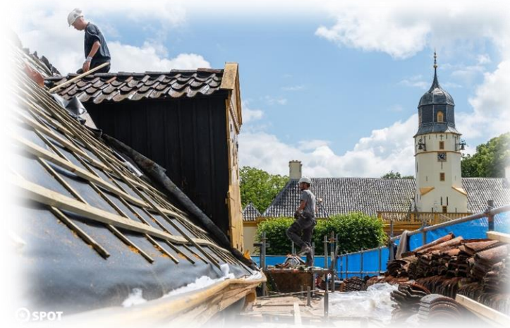
Plaatsing van isolerende folie op het dak van De Boerderij. Foto Spot Companion.
