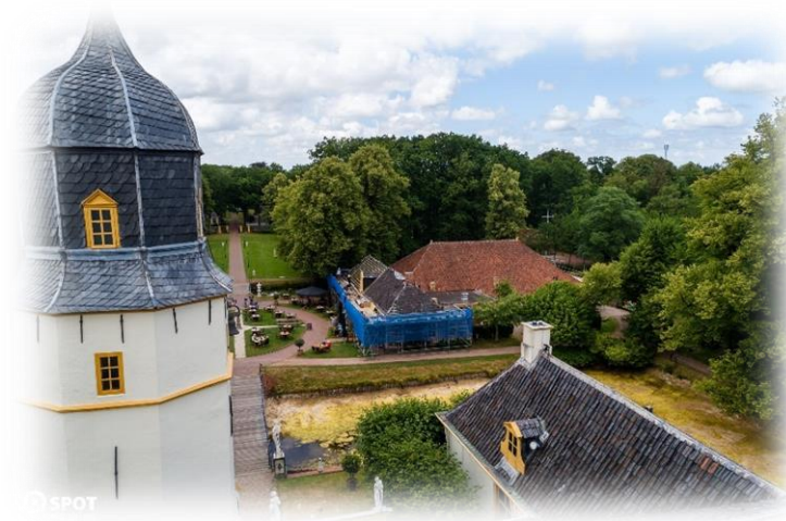
Zicht op restauratie van De Boerderij in 2019. Foto Spot Companion.
