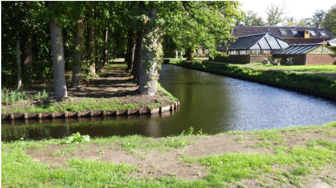
De gracht na aanbrengen van de beschoeiing
